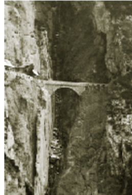
Ersterbauung der Flexenstraße 1895-1897 – Hölltobelbrücke
