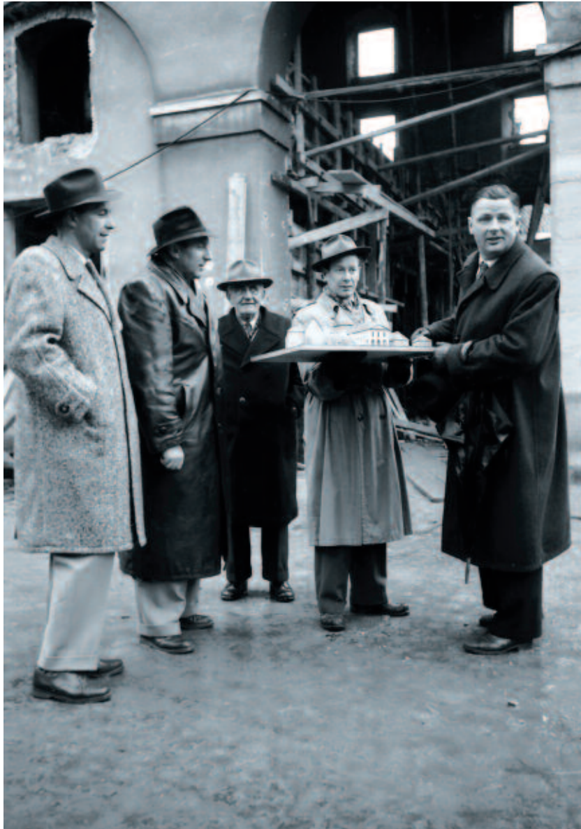
Der Beginn der Umbauarbeiten des Kornhauses. Von links: Architekt Wilhelm Braun, Baumeister Walter Rhomberg, Josef Neubauer vom Stadtbauamt, rechts vom Modellträger Bürgermeister Karl Tizian, der den Theaterbau politisch durchgesetzt hatte.
